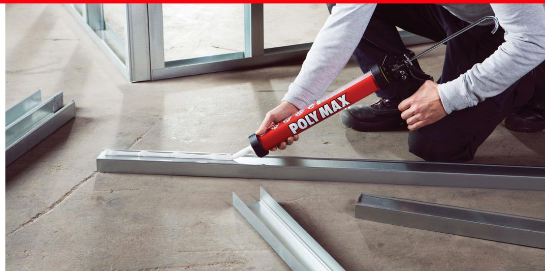
La précision est maximale ! De plus, comme la colle remplace la bande d'isolation phonique, la pose fastidieuse de cette bande sur la face inférieure des profilés n'est plus nécessaire. Cela signifie qu'aucun pont acoustique ne peut être créé par les vis.
